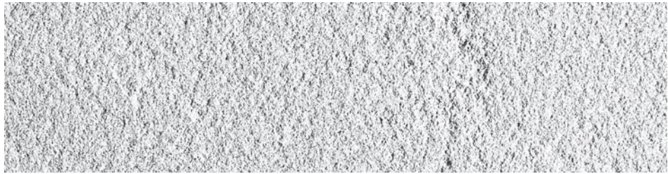
Maschinell mit einer Sandstrahlanlage überarbeitet. Bildmassstab 1:1
